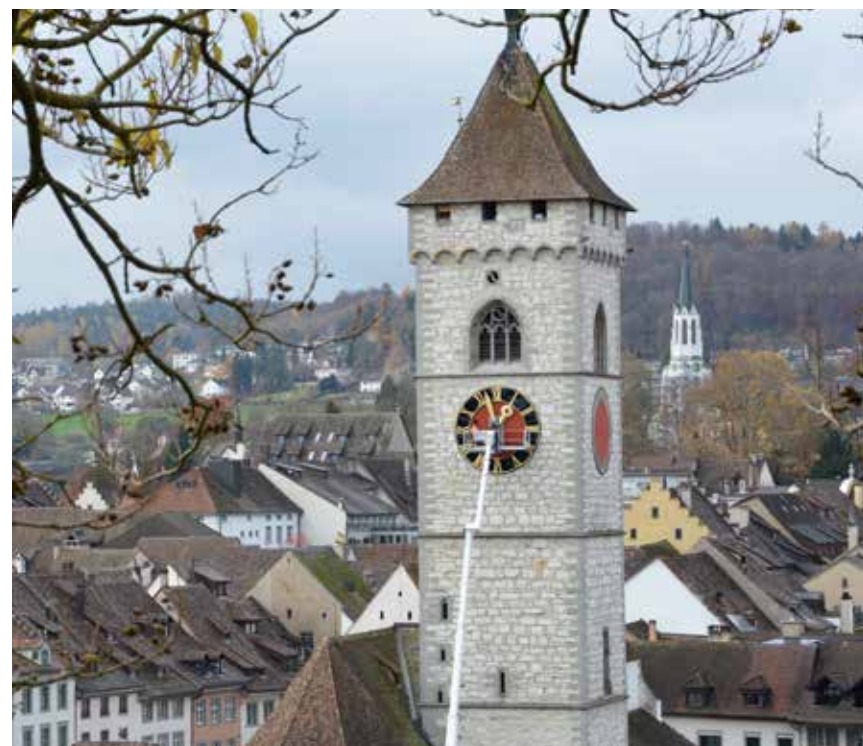
Die Montage der renovierten Zifferblätter und der Zeiger der Turmuhr am St. Johann wurde gestern abgeschlossen. Bild Ronja Bollinger
